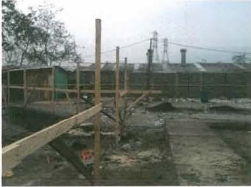
FOTOS N° 3 Y 4 TRAZADOS Y MOLDAJES
