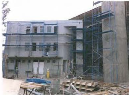
FOTOS N° 5 Y 6 OBRAS DE HORMIGÓN Y CAJA ASCENSOR
