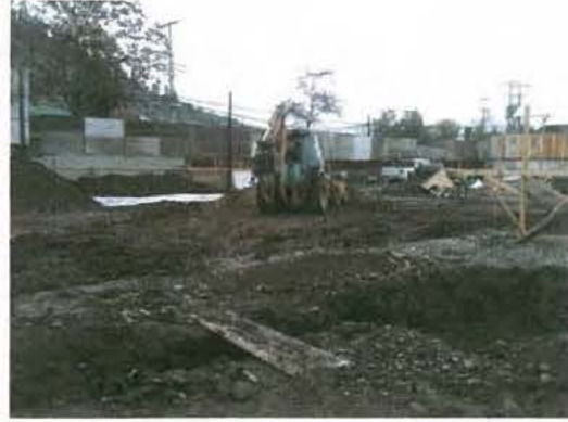
FOTOS N° 1 Y 2 LIMPIEZA Y EXCAVACIONES
