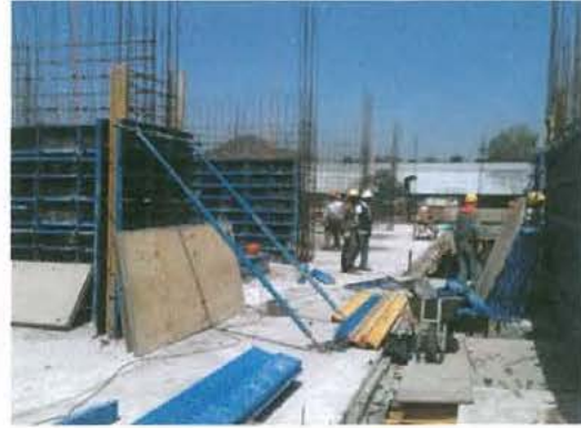
FOTOS N° 3 Y 4 TRAZADOS Y MOLDAJES
