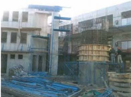
FOTOS N° 5 Y 6 OBRAS DE HORMIGÓN Y CAJA ASCENSOR
