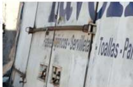
Instalación de barra de fierro en puerta de acceso al container bodega. Doble candado.
