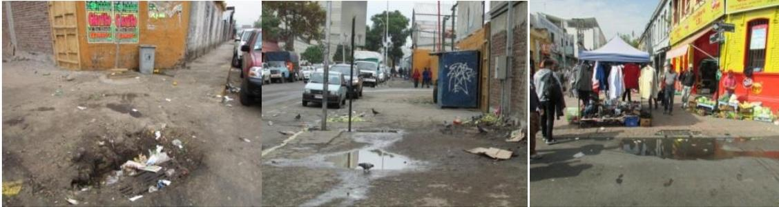
Imagen N°27. Registro fotográfico de imperfecciones de aceras y veredas que permiten la acumulación de residuos, generando contaminación visual, presencia de vectores Sanitarios y edor indeseable.
