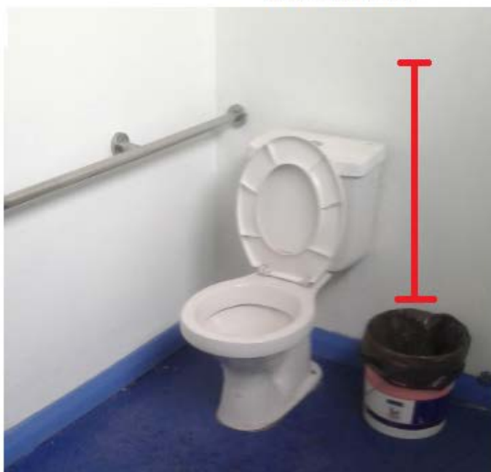
Falta baranda vertical
