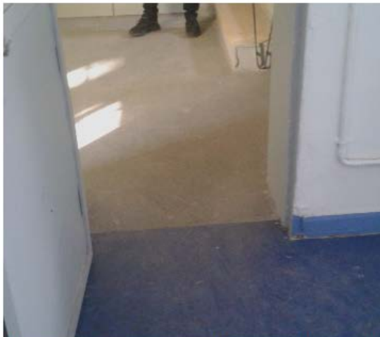
Primer acceso, ancho no adecuado.
